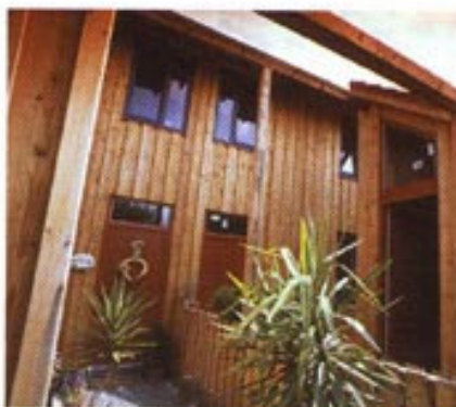
A szakszerűen feldolgozott fából készült és lazúrral rendszeresen gondozott homlokzat ellenáll az időjárás káros hatásainak
